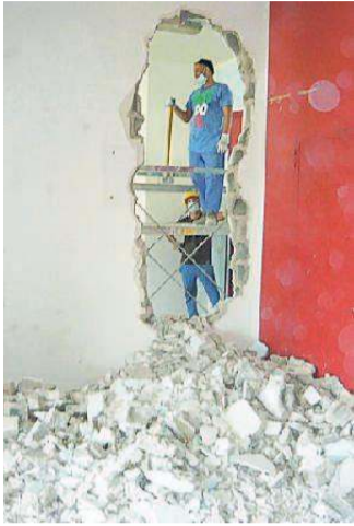
Un momento dei lavori
